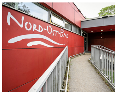
Das Nord-Ost-Bad ist wegen Fliesenschäden ab 1. Oktober geschlossen. KERSTIN KOKOSKA/FFS
